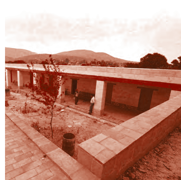
Exterior de la Casa de los fiscales, intervención contemporánea.
